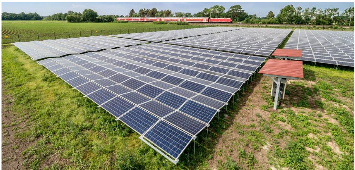
Bild 9: Beispiel einer Photovoltaikfreiflächenanlage der Firma Jurchen-Technology, Ost-Westausrichtung, Quelle: www.jurchen-technology.de/projekte-erfolge/ , letzter Zugriff: 23.01.2026
