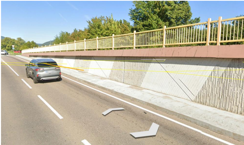
Abbildung 17: Sicht von Straßenverkehr K6 auf PV-Freifläche 2
