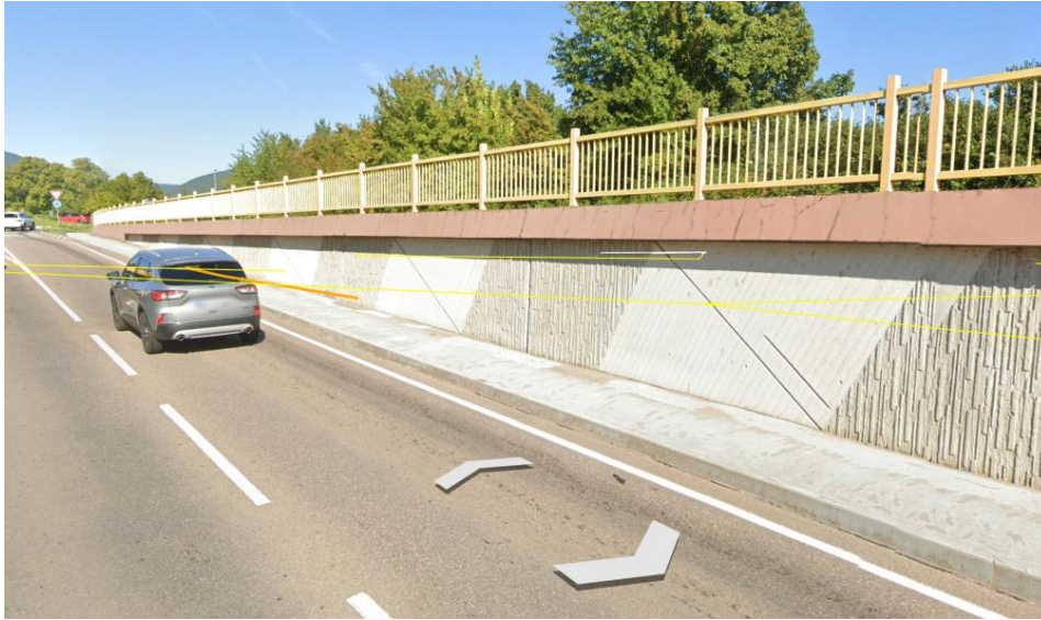
Abbildung 23: Sicht von Straßenverkehr K6 auf PV-Freifläche 2
