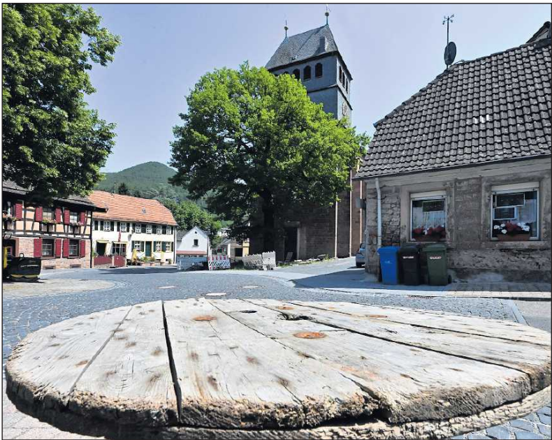
Die Bauarbeiten rund um die Kirche sind noch immer nicht fertig gestellt, hier ein Foto von Juni.
