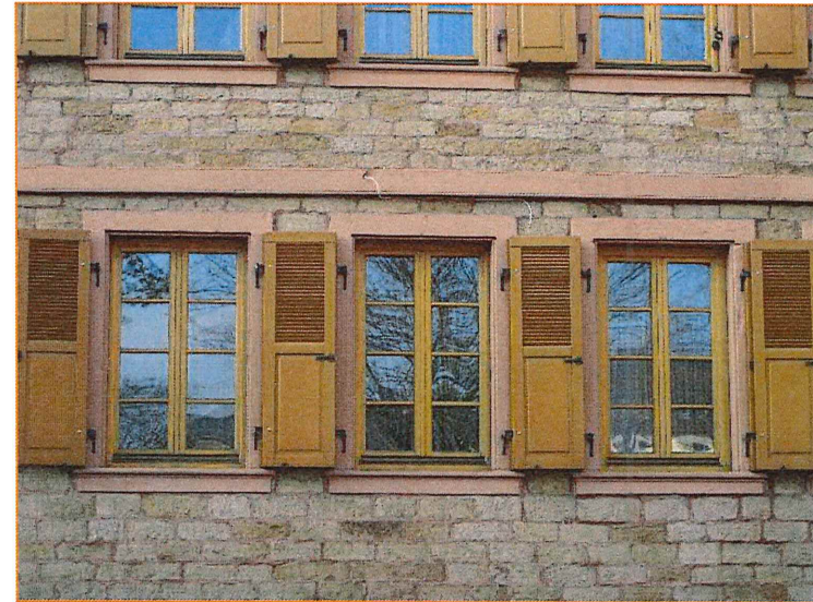
Abbildung 20: Fenster mit Sprossenteilung, Klappläden und Sandsteingewänden
