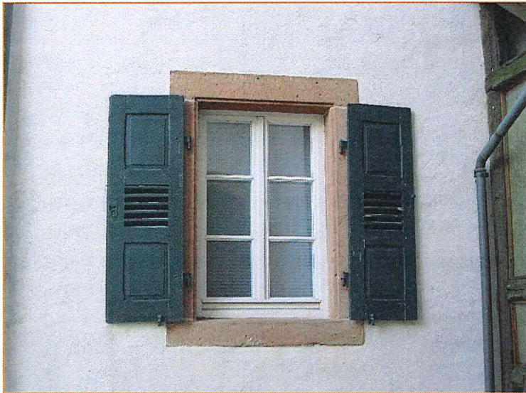
Abbildung 22: Fenster mit Sprossenteilung, Klappläden und Sandsteingewänden
