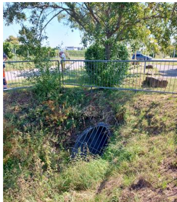
Abbildung 9 Maikammer, Durchlass Alsterweilerer Bach unter L516
