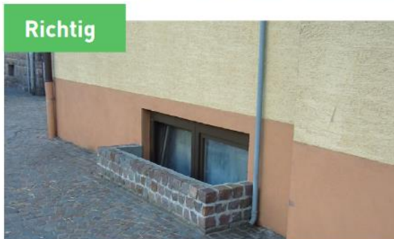
Abbildung 23 Schutz tiefliegender Gebäudezugänge [9]
