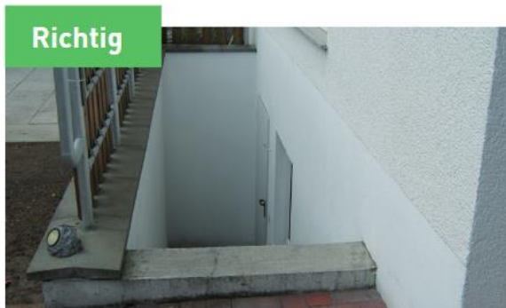
Abbildung 22 Schutz tiefliegender Gebäudezugänge [8]
