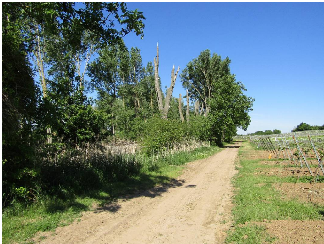
Foto 7: westlicher Teil der Vorhabensfläche; Blick nach O entlang des Riedgrabens mit aufgelichteter Pappelreihe; 1.6.2021
