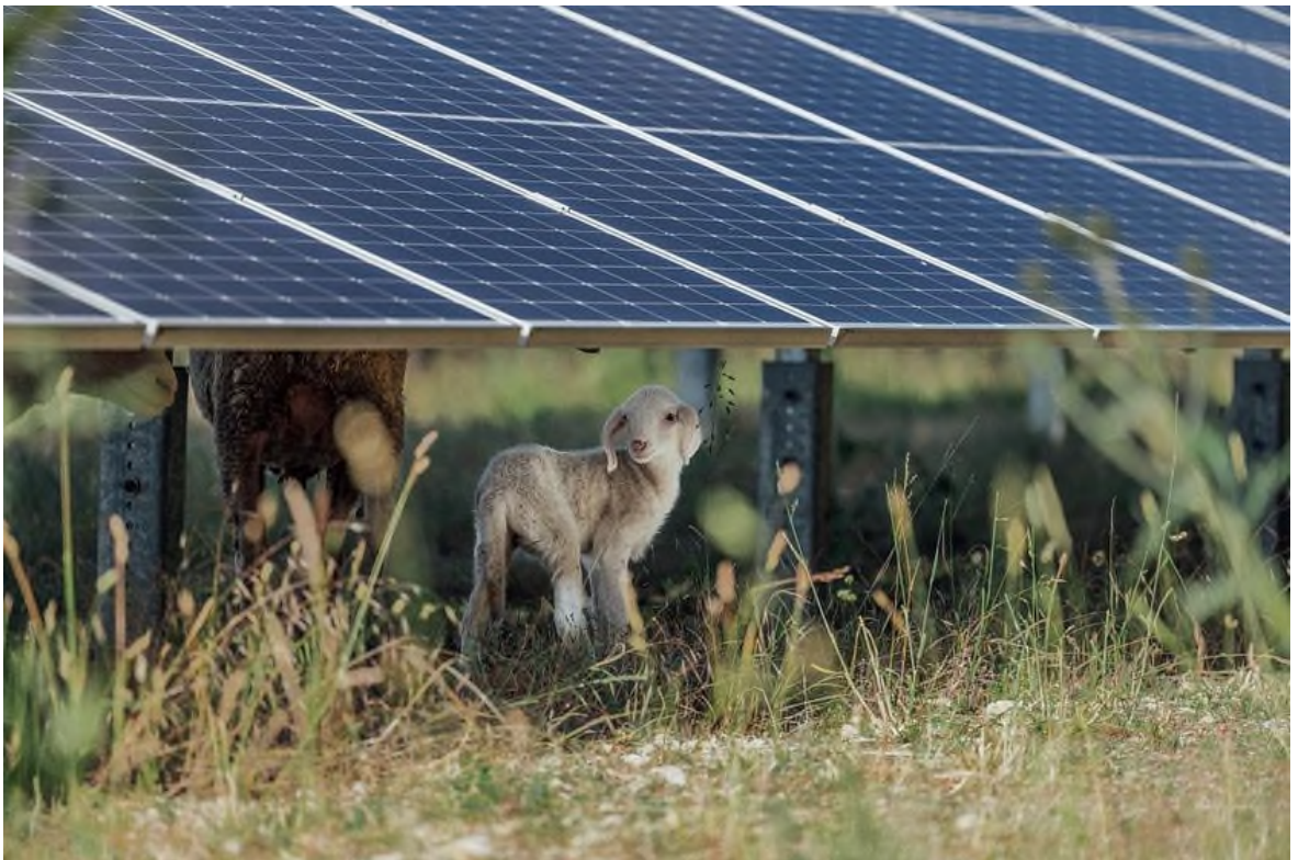
Bild 14: Beispiel PV-Anlage mit Beweidung
