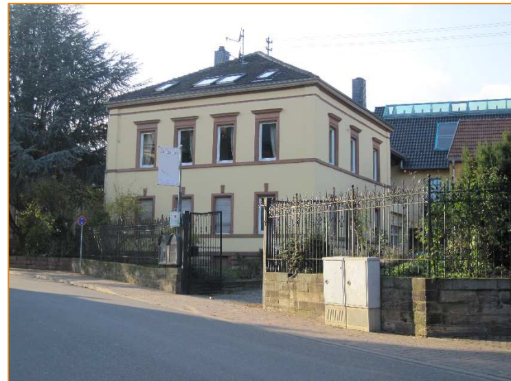
Abbildung 29: Einfriedung mit Mauer und Stabgitterzaun | Weinstraße Nord
