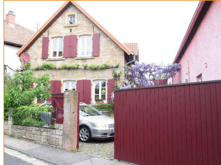
Abbildung 28: Einfriedung des Grundstücks durch Mauer, Begrünung und Tor, Material und Farben vom Gebäude wurden aufgenommen | Weiherstraße
