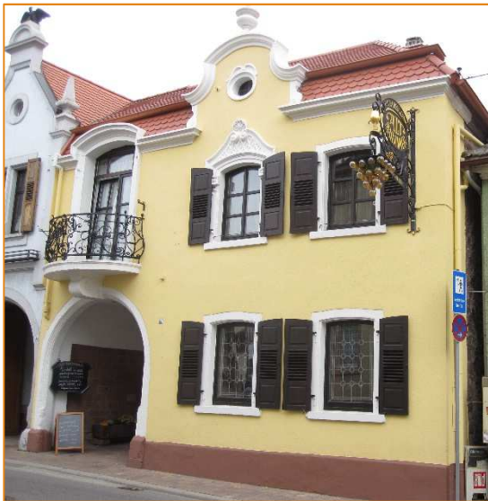
Abbildung 19: Ortsbildprägendes Gebäude mit Rundboden aus Sandstein, Sandsteingewänden, geteilten Fenstern und Klappläden | Weinstraße Nord
