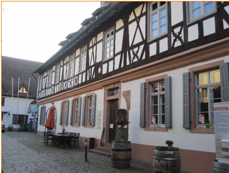
Abbildung 14: Gegliederte Fassade mit Kombination aus Naturstein, Putz und Fachwerk | Marktsstraße
